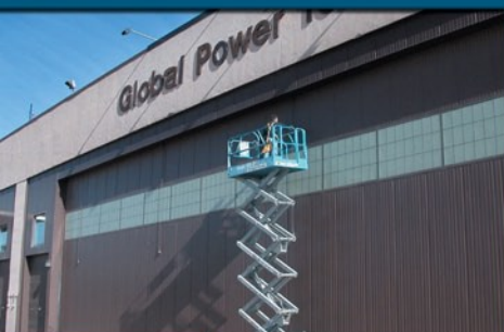
• Tilt-Up Hangar Door
